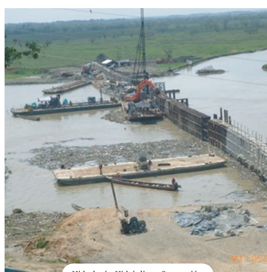
Hidrología, Hidráulica y Socavación Interventoría obras de protección emergencia río Cauca. La Mojana, sitio Santa Anita
