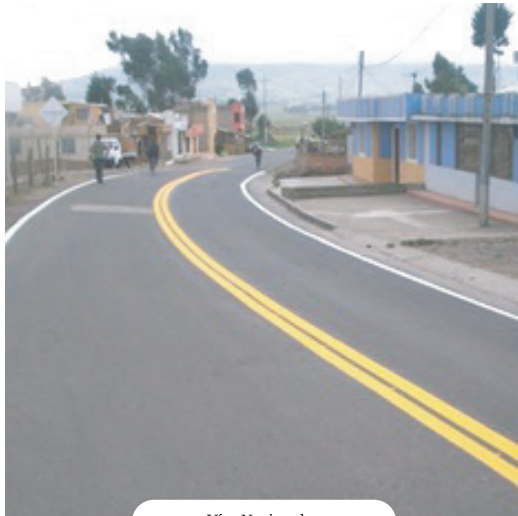
Vías Nacionales Interventoría construcción vía Guachucal - El Espino Nariño (Plan 2500)
