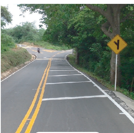
Vías Nacionales Interventoría obras de mejoramiento vía Tubará - Autopista al mar Atlántico
