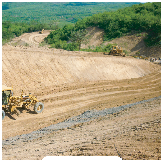
Vías Nacionales Interventoría construcción vía Variante - Tubará Atlántico
